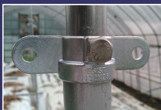
同じパイプの反対側にスノーレジスト中を取付ける。
