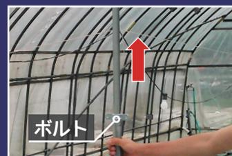
支柱パイプ(細)を差し込み、レジスト天まで伸ばした状態でボルトを固定。
