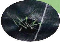
補修テープ未使用時
